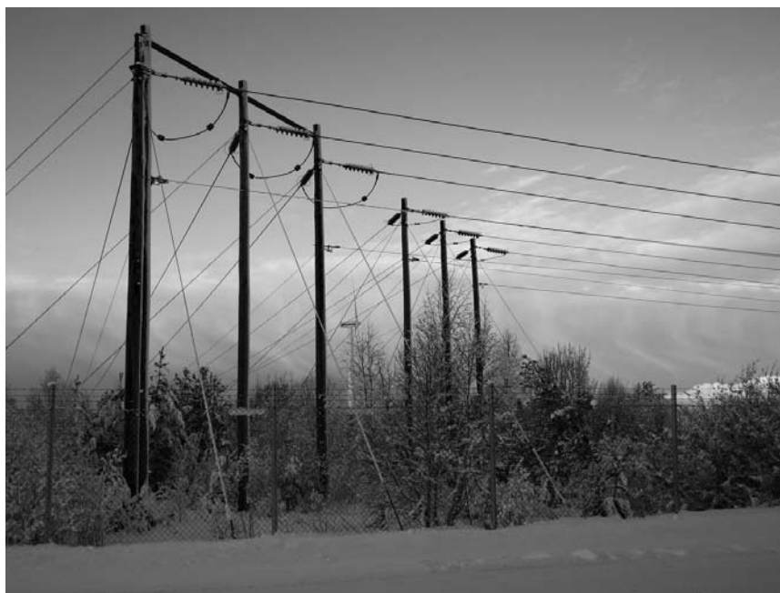
Kraftledningar och vindkraft – vindkraftverk ansluts till elnätet via kablar i marken.
